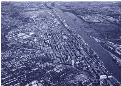
Abb. 1 Werksfläche der BASF in Ludwigshafen
