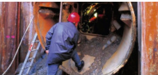
Umbau Alte Emscher
