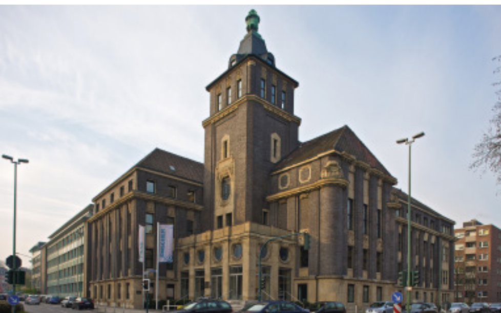
Hauptverwaltung der Emschergenossenschaft
